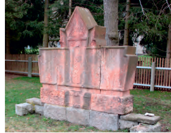
Nach der Instandsetzung wird eine Bronzetafel die weltumspannende Botschaft verkünden: Nie wieder Krieg. Foto: H. Zink
